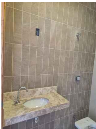
Fotos gerais do ambiente Banheiro esquerdo
